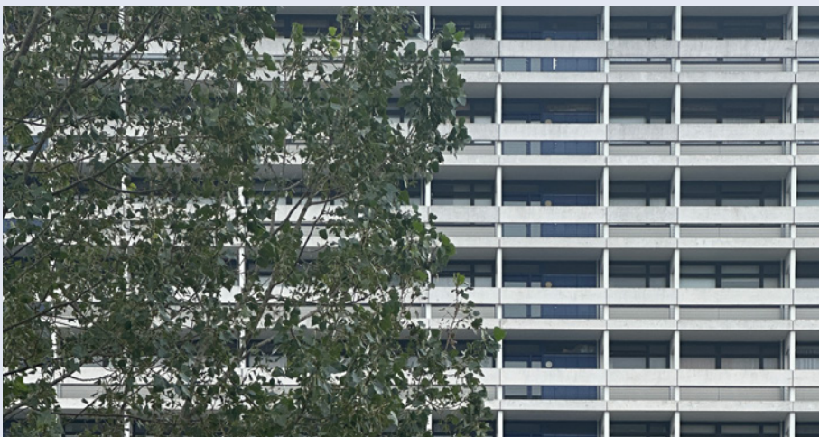
Høje Gladsaxe 1966. Arkitekter Jørgen Juul Møller, Kai Agertoft, Hoff og Windinge og Alex Poulsen. Foto: Nicolai Bo Andersen.
