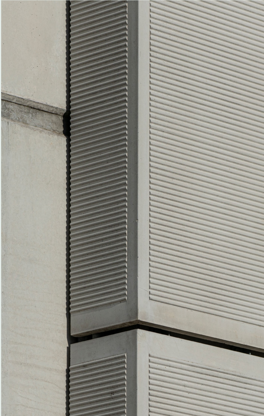
Gyldenrisparken 1967-69. Arkitekter Henning Hansen & Erik Carlsen, Jens Frølund, P.E. Malmstrøm Rådgivende Ingeniører. Renoveret 2006-14, Tegnestuen Vandkunsten og Witraz Arkitekter, landskabsarkitekter Algren & Bruun. Wissenberg Rådgivende Ingeniører A/S. Foto: Bjørn Pierri Enevoldsen.
