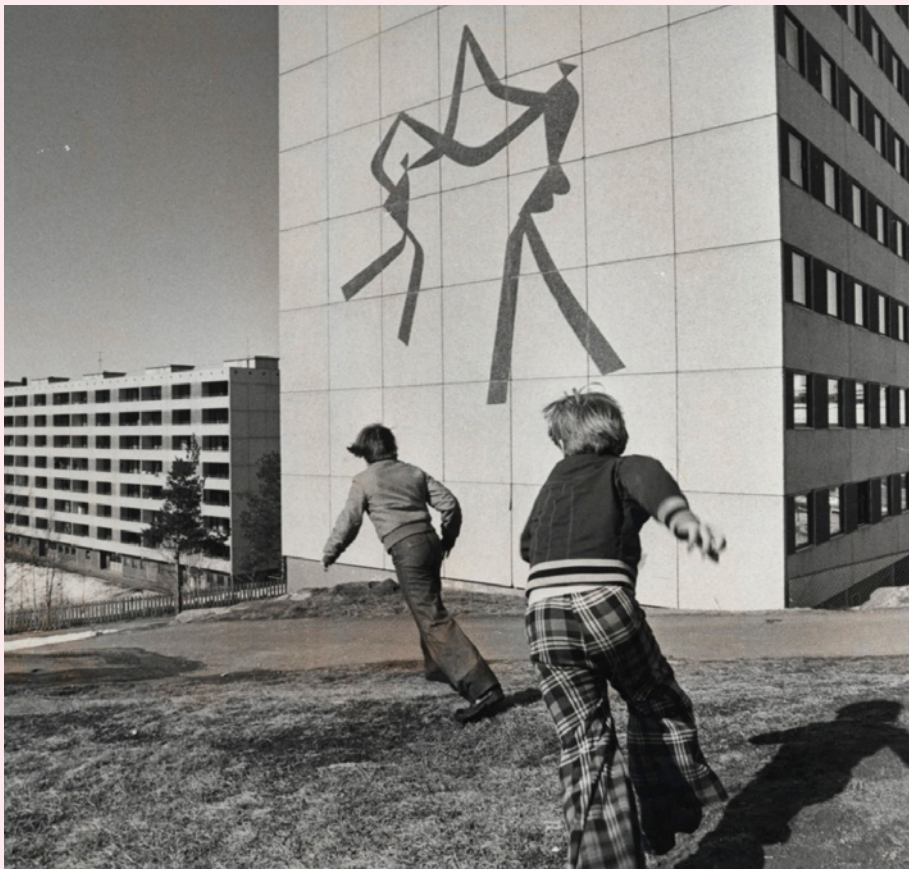
Foto fra OBOS av Knut Steens integrerte utsmykning av den ene lamellblokkens kortvegg.
